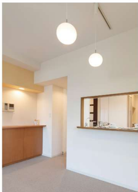
カウンターの中に電話端子、光通信を引込んでいます。
