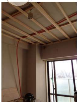
北側の部屋から光通信をCD管で渡して行きます。
